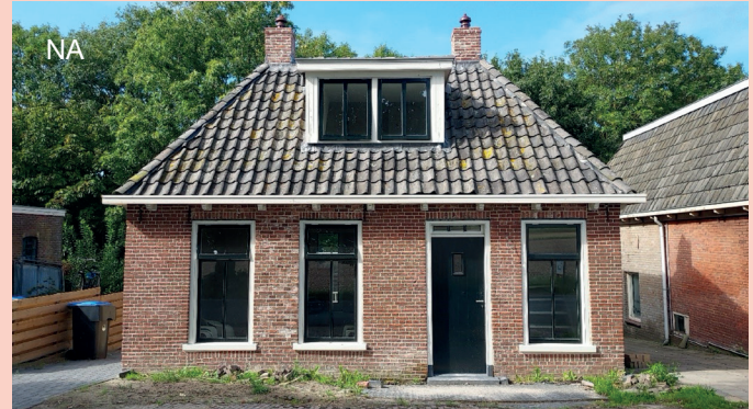
Dezelfde woning na de werkzaamheden. De voorgevel is teruggebracht in originele staat en de woning is volledig gerenoveerd. Daarbij is de woning ook gelijk verduurzaamd. Het project is tot stand gekomen in samenwerking tussen de eigenaren en Stichting herstel dorpen en Bildtdijken.
