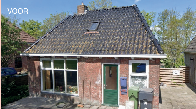
De woning voor de renovatie. Op de foto zijn de niet-originele kozijnen, voordeur en dakpannen te zien. Een van de schoorstenen mist. De woning heeft onderhoud nodig en is niet geïsoleerd; ruimte voor verbetering.
