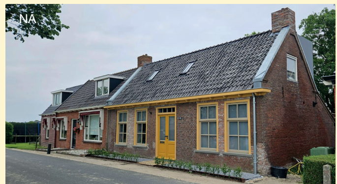
De woning na oplevering van de werkzaamheden in juni 2024.
